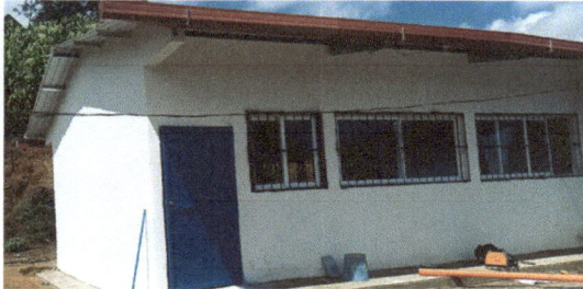
Foto1: Vista de pared en donde ya fue rehabilitada.
