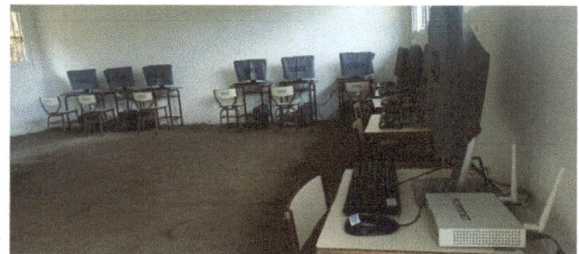
Foto 6: Entortado de cemento dentro del aula y corredor.
