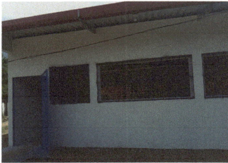
Foto 3: Fotografía que evidencia la reparación de repello y cernido de paredes.
