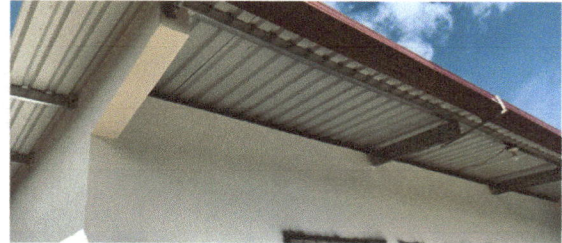
Foto 2: Vista donde se puede observar instalados los renglones de trabajo cubierta de techo, estructura de techo y canales de bajadas de agua.
